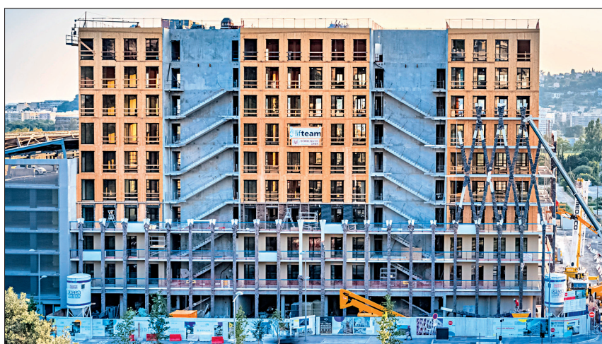
Neun der zehn Geschosse des 35 m hohen und 55 m breiten Bürobaus „Palazzo Méridia“ in Nizza sind in Holzbauweise ausgeführt. Die beiden Stahlbeton-Treppenhäuser dienen der Holzkonstruktion als Aussteifung.
